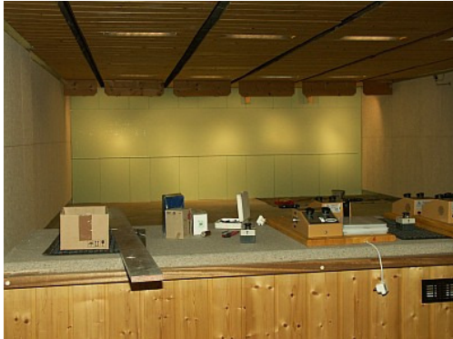
Warten auf die Montage der Zuganlagen.
