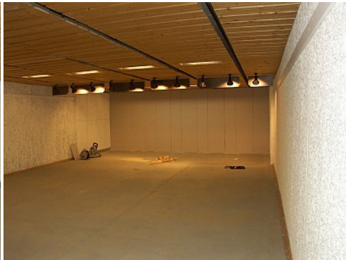
...und von hinten. Die doppelwandige Trennwand steht.
